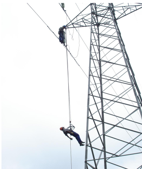
Foto 2. Treinamento para resgate de eletricista acidentado em linhas de transmissão. O eletricista de capacete azul já desconectou o eletricista “desmaiado” do cabo condutor e conectou na corda de resgate, onde o mesmo está sendo resgatado pela equipe.
