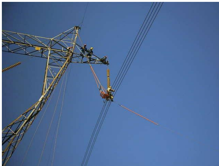
Foto 5. Eletricista entrando no potencial utilizando a cadeira de traslado nas manobras de troca de isoladores LT 440kV circuito simples.
