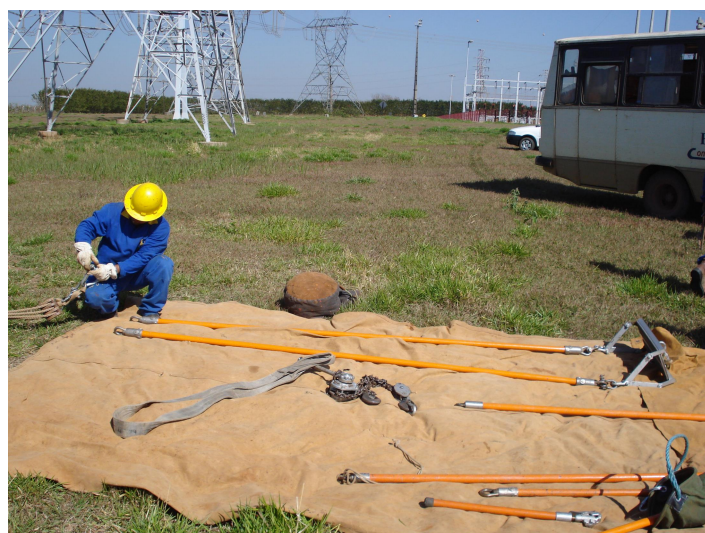
Foto 6. Balancim que substituiu a cadeira de traslado sendo montado.
