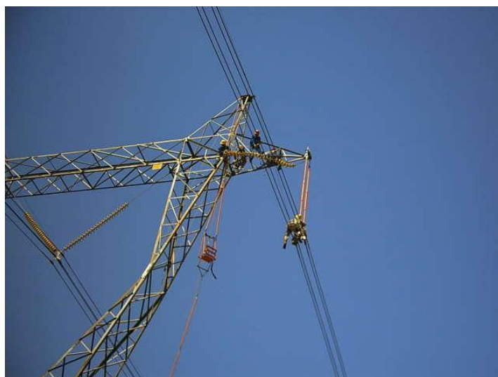
Foto 8. Cadeia de isoladores sendo reparada em cima da estrutura metálica pelos eletricitas de LV.
